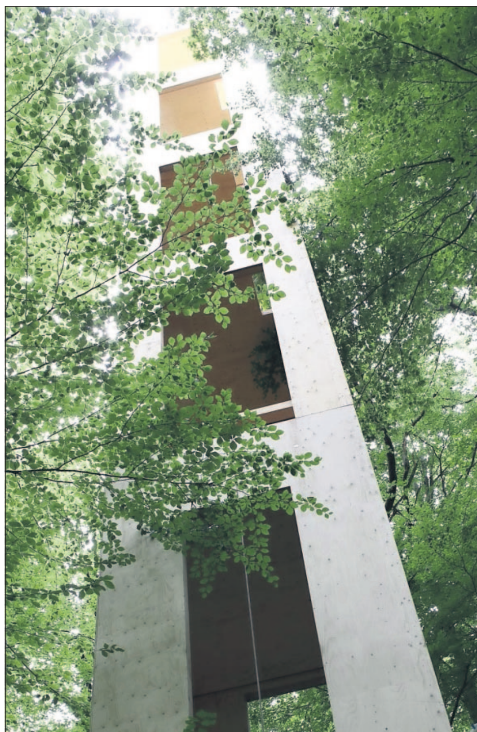
VON UNTEN Überraschend. Das Turmholz ist unbehandelt, damit nicht Ausdünstungen die Messergebnisse verfälschen können. (fotos: sven paustian)
