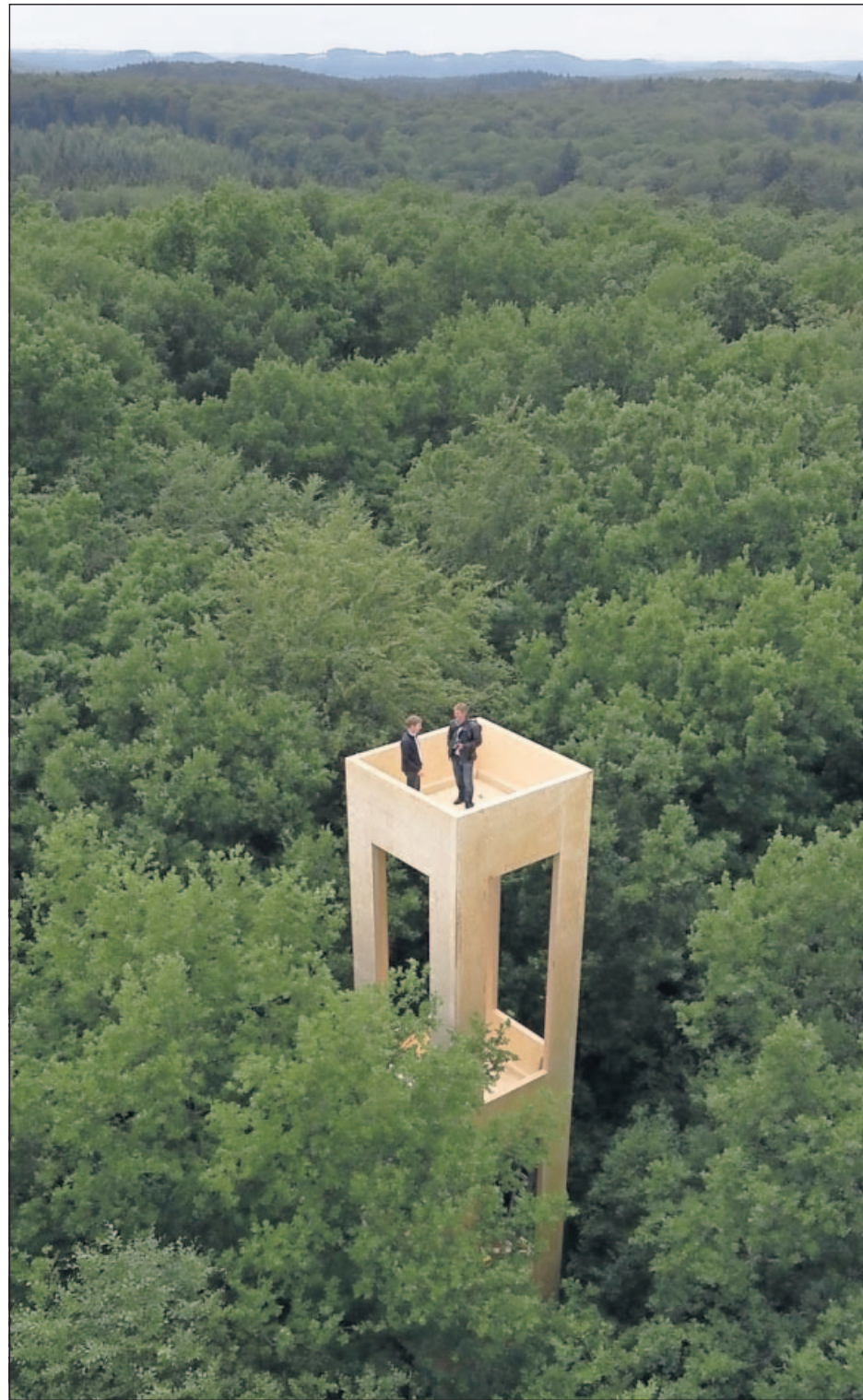
VON OBEN Biologe Michael Lakatos (links) und Statiker Frank Lederer auf dem Turm. Das Bauwerk steht seit Juni, eröffnet wird es jetzt am Donnerstag.
